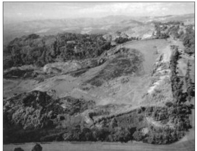
Fig. 3. Excavación C1 indicando la dirección de la ruptura, su efecto retrogresivo y la ruptura de los materiales adyacentes (Gomes et al., 2001)
